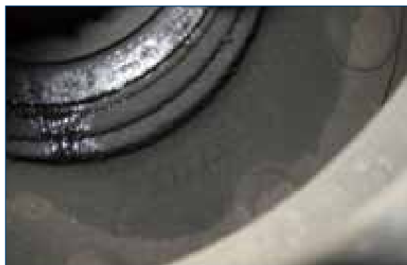
图 4：漏油，需要更换油封
